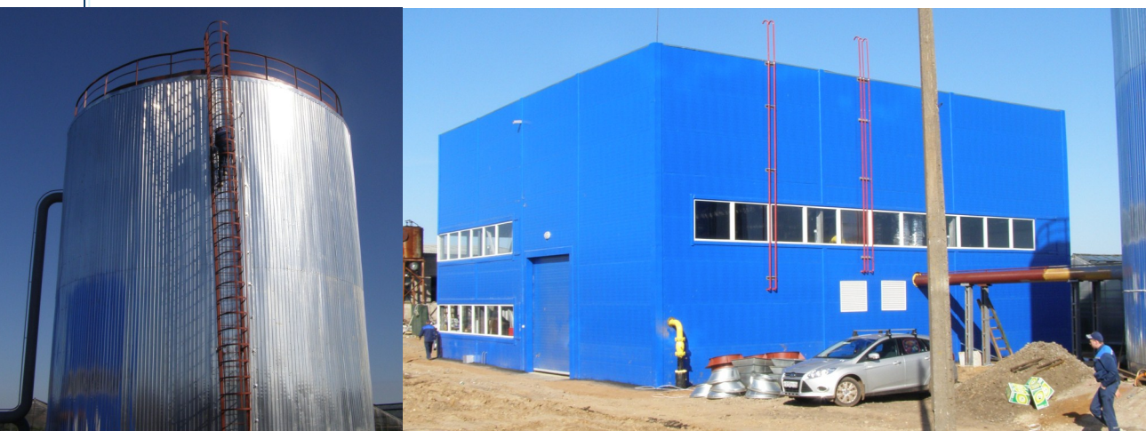
пос. Переслегино, котельная 28 МВт
