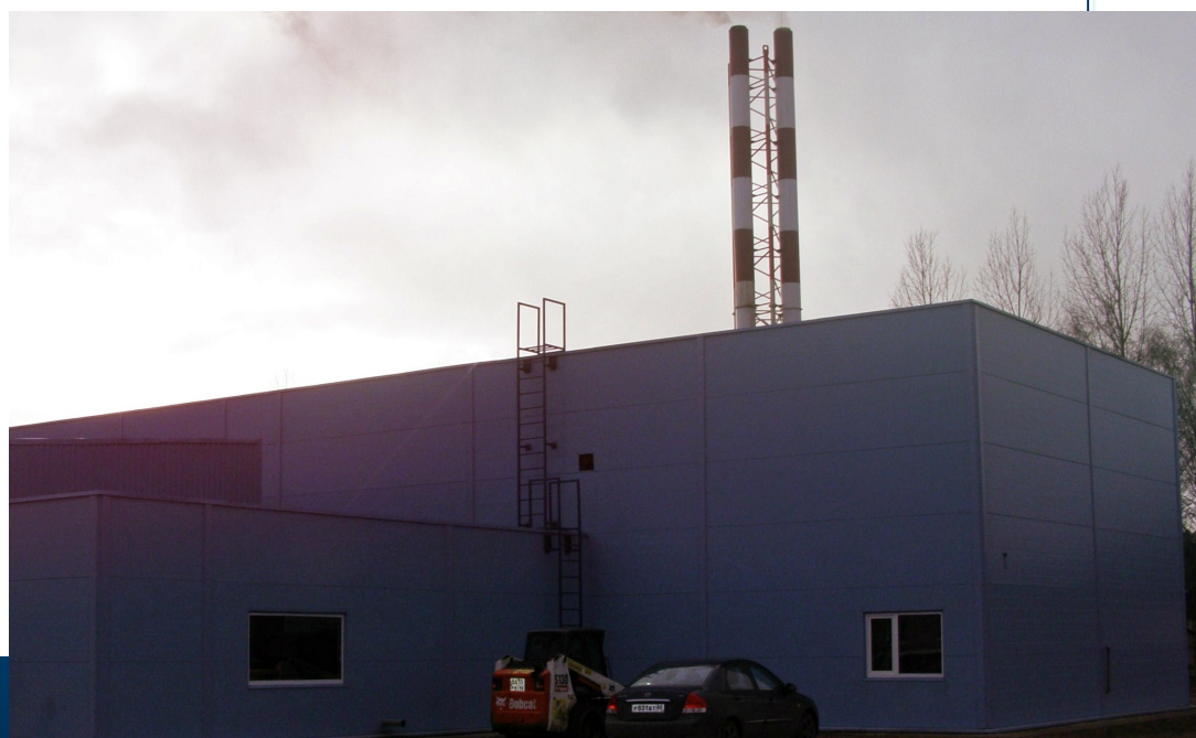
г.Гдов, котельная на торфе
